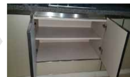
① 하부장 선반 조립 상태
